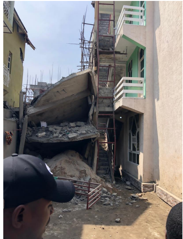
溶岩によって倒壊した建物
